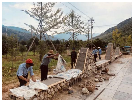
图8 葛家村村民参与作品施工现场
