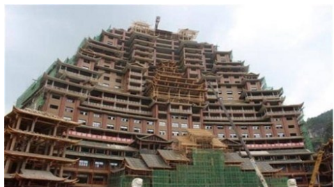
图3 D县某村的“面子工程” ——水司楼
