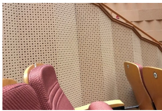
图4 水立方比赛场地墙面 多孔吸音材料
