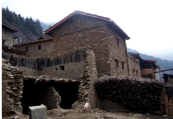
图2 茂县河西村的石墙板屋
