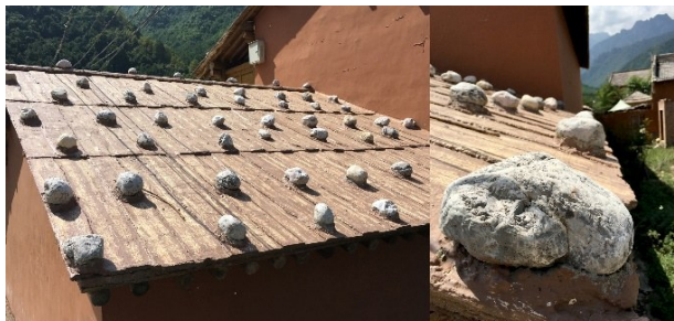
图5 宕昌鹿仁村板屋顶部的“乱石压木片”
