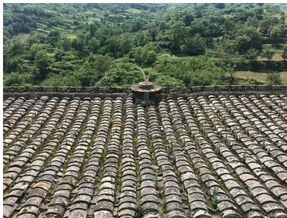
图4 文县铁楼乡板屋屋脊正中的“沙尕帽”造型
