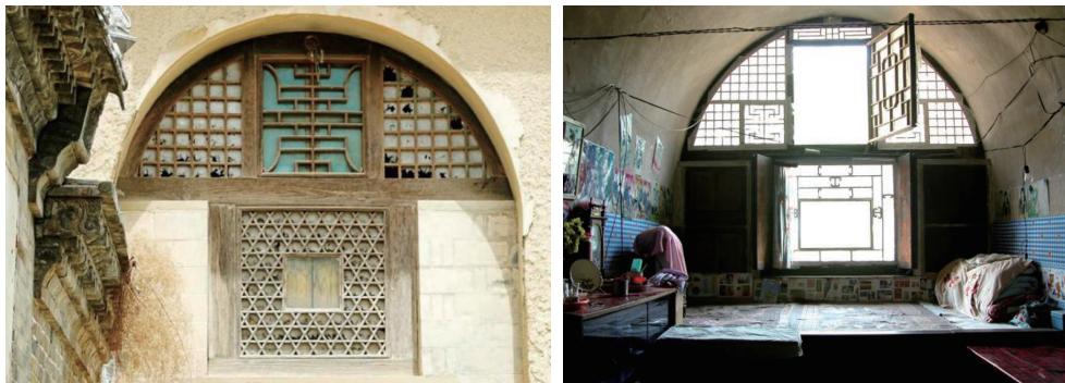
图2 陕北窑洞民居满拱大窗的外观与内部
